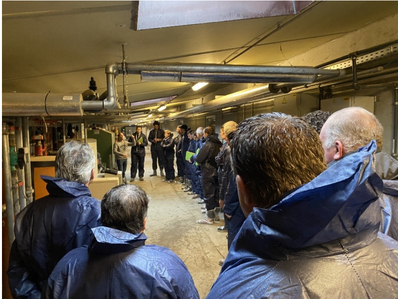
Foto 5: Uitleg bij de technische ruimte in de gang van de stallen.
